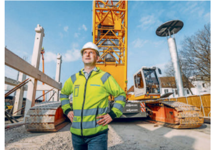
Projektleiter Thomas Behnisch vor dem 300-Tonnen-Raupenkrane. Wegen der Enge hat der Spezialkran kaum Bewegungsspielraum.
